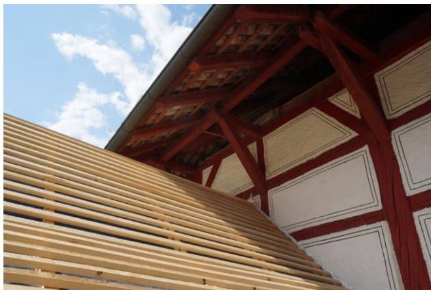
Das Dach wird neu gedeckt
