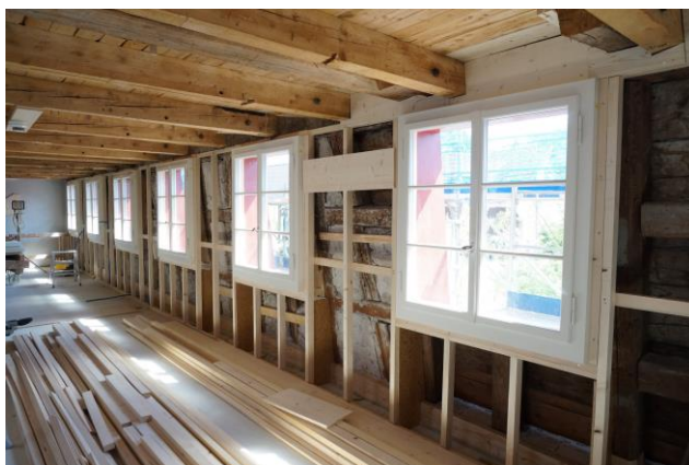
Fenstereinbau und Schiftung der Wände
