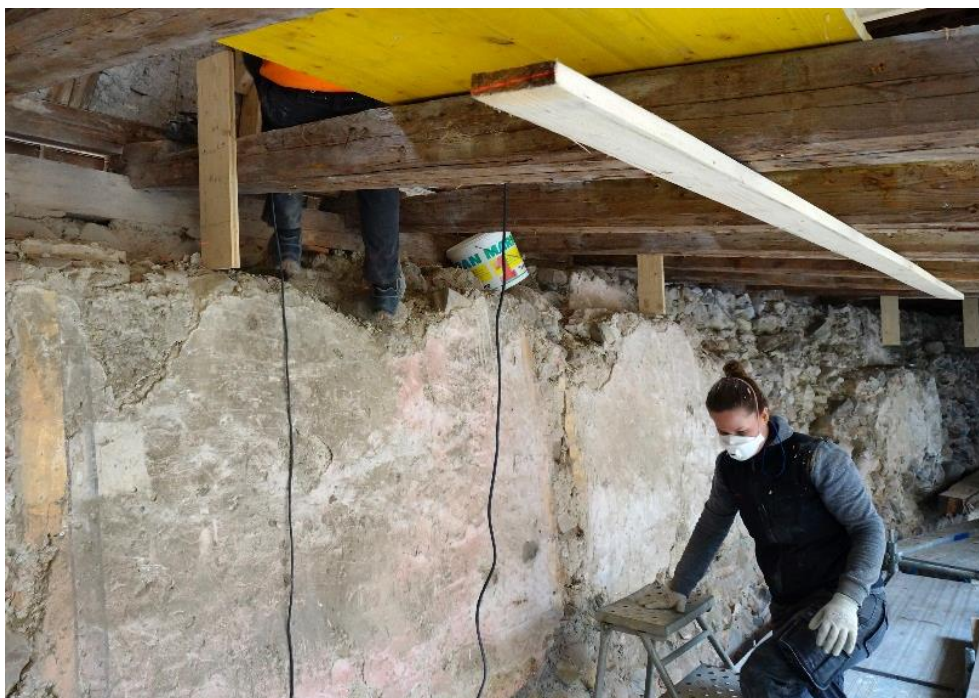
DSCo4605b.JPG Die Abtragarbeiten
